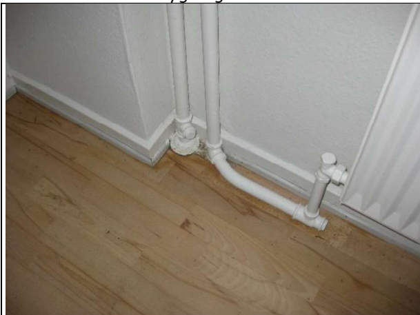
Oprindelige stigrør er genbrugt ved ombygningen – lejl. 6.0.8
