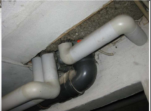
Tvivlsom udstøbning, manchete fastholdt til plastrør
